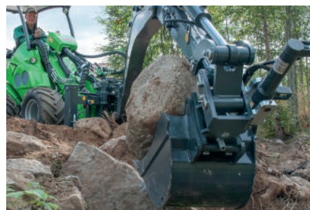
Retroexcavadora 260 con cazo de 40 cm con dientes + cazo de limpieza
